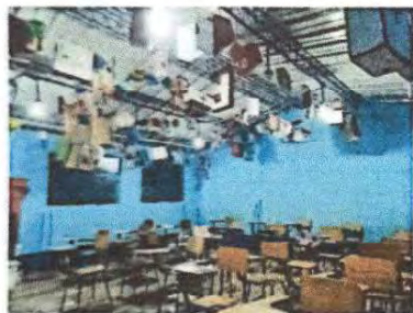
Foto 21: Sustitución de tomacorrientes en aulas del módulo 1 y 2.
