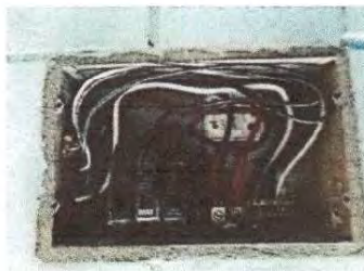
Foto 22: Sustitución de flipones en la central de la dirección.
