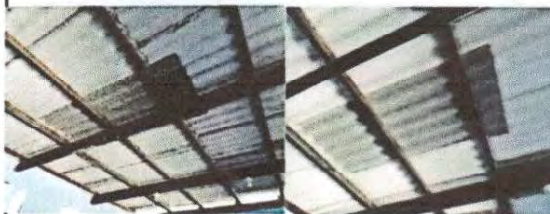
Foto 4: Sustitución de lámina de corredor del módulo 1.
