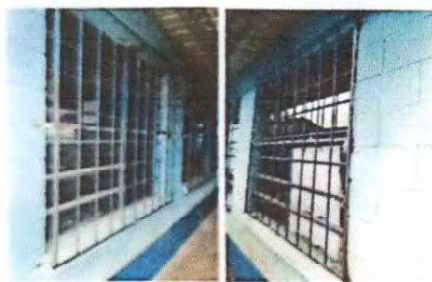
Foto 9: Reparación de balcones del módulo 2
