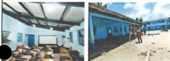
Foto 1: Sustitución lámina del interior del aula 1 y 2 del módulo 1
