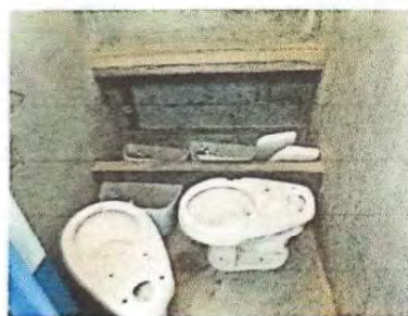
Foto 15: Sustitución de llaves y tubo en meninjerío.
