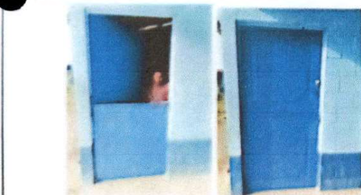
Foto 5: Sustitución de chapa de la dirección en el módulo 1
