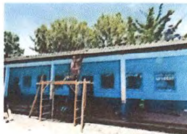
Foto 2: Sustitución de reglas de aula 1 y 2 del módulo 1
