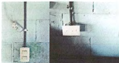
Foto 20: Sustitución de cableado y tomacorrientes en aulas del módulo 1
