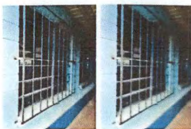
Foto 10: Reparación de balcones y cambio de vidrios de ventanales del módulo 2
