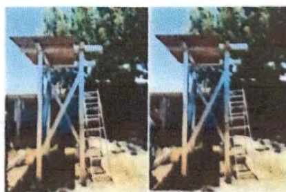
Foto 12: Servicios de agua potable y muro perimetral
