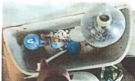
Foto 13: Sustitución de accesorios de inodoro de batería de baños de niñas.
